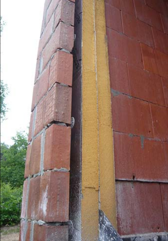
Als spouwisolatie werd geopteerd voor twee platen Eurowall (82 mm) die geschrant geplaatst werden
