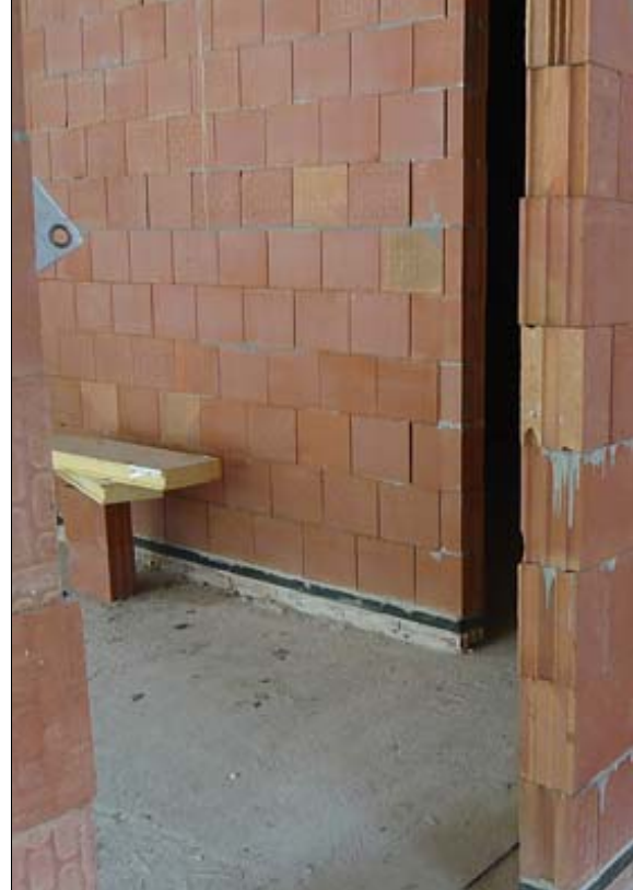
Bakstenen zijn thermisch inert: ze kunnen overdag warmte opslaan en die 's nachts trager afgeven
